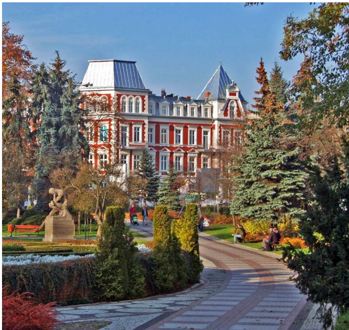
Fot.18. Wyremontowana kamienica Wojska Polskiego 1, listopad 2011
