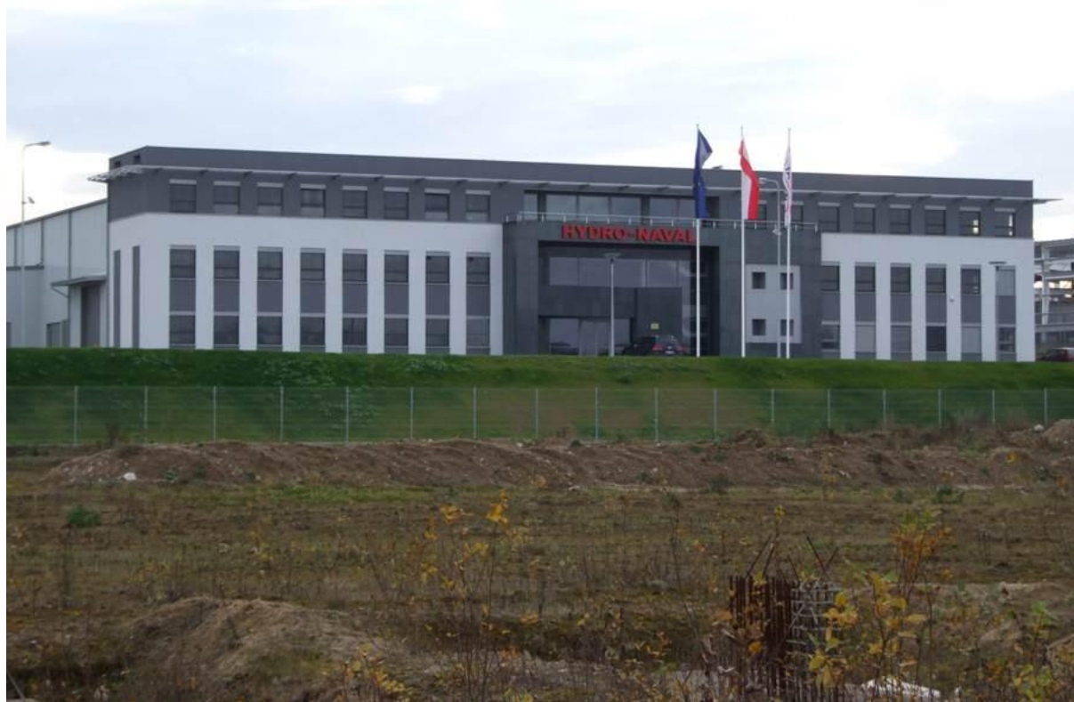
Fot. 8 Nowopowstały zakład przemysłowy na terenie SSSE, ulica Braci Staniuków, Słupsk
