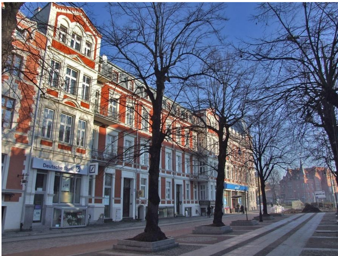
Fot. 21 Remont części ulicy Wojska Polskiego wraz remontem kilku kamienic, XI 2011
